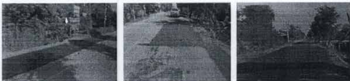
โครงการซ่อมแซมถนนคันกั้นน้ำชลประทานแอสฟัลต์ติกคอนกรีต ม. ๑-๓
