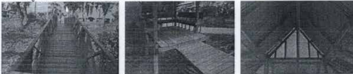
โครงการปรับปรุงซ่อมแซมสะพานทางเดินเข้า รพ.สต.ท้ายเกาะ และ ศาลาพักผ่อนโดยสาร ๕ แห่ง ม.๑, ม.๓, ม.๔
