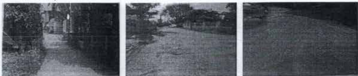
โครงการปรับปรุงซ่อมแซมผิวจราจรและไหล่ทางซอยต่างๆ ม.๑ , ม.๒ , ม.๓
